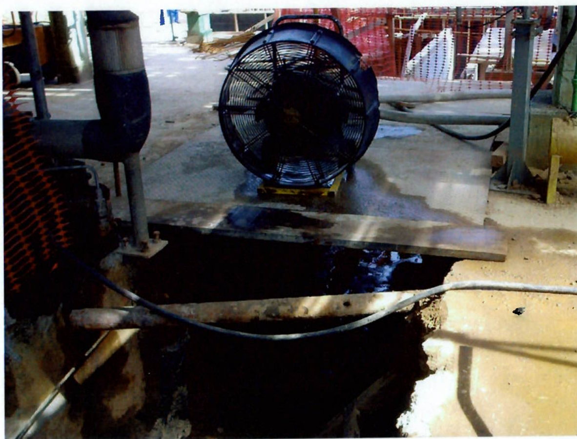
Foto 5 – Ventilador de pressão positiva movido por turbina à água.
